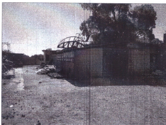
Fig. 7- Area industriale con manufatti ad un piano fuori terra
